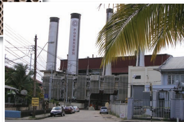
PowerGen Power Plant, Port of Spain, Trinidad.
